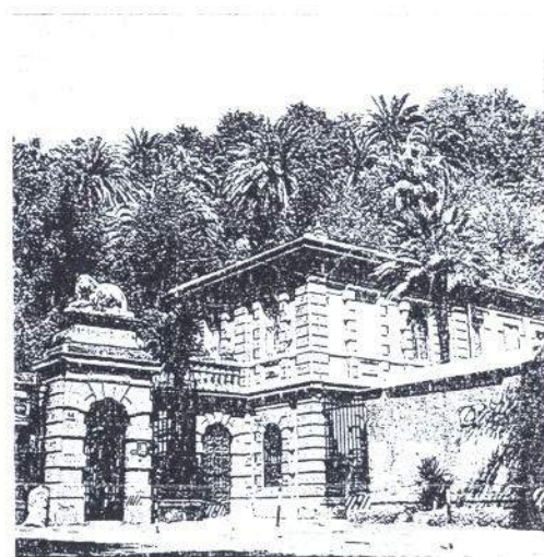
Ex portineria di villa Pignone. Il piccolo edificio è caratterizzato da un forte bugnato, che conferisce plastiche vibrazioni chiaroscurali alla facciata.
