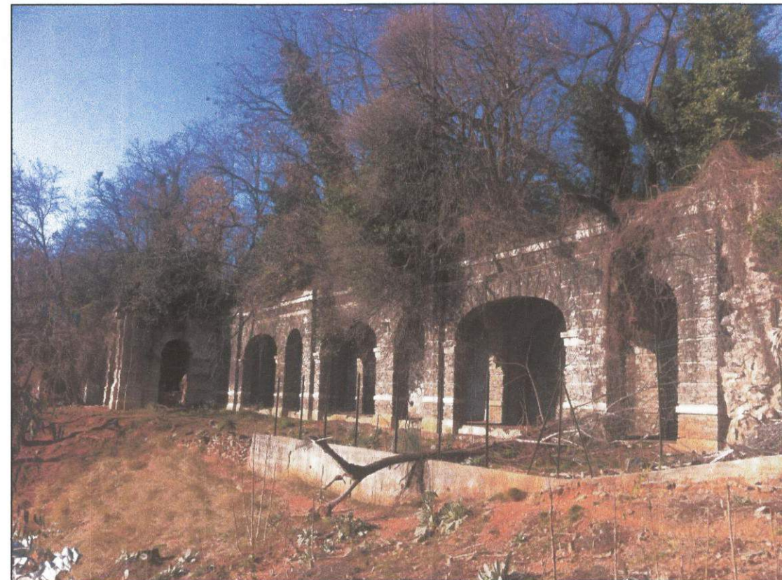
FOTO 6 - Il basamento lato sud-est
