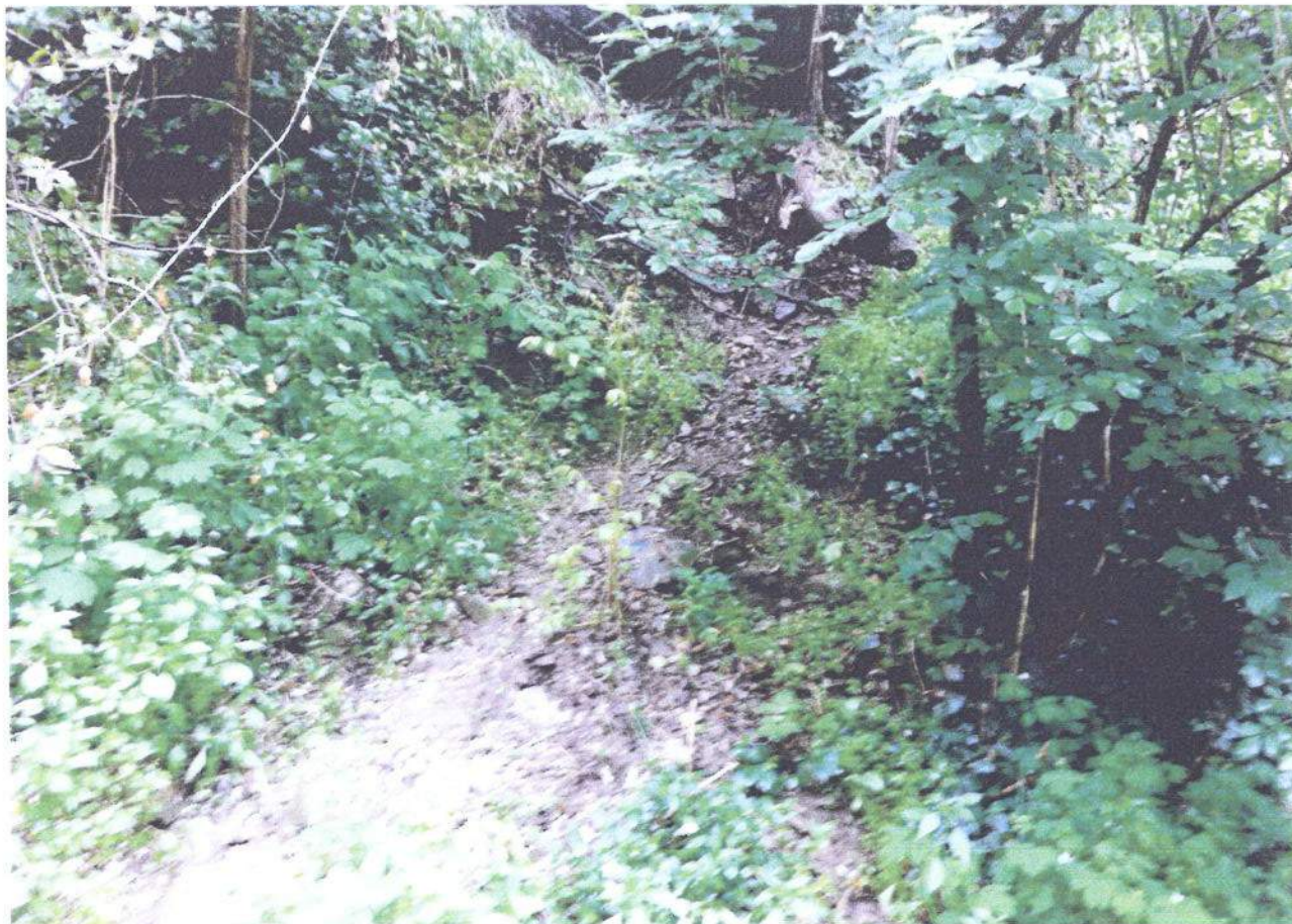
FOTO 6: Tratto completamente franato
